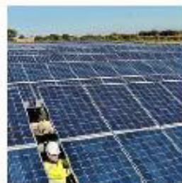
Une ferme solaire pourrait voir le jour près de l'aéroport.
